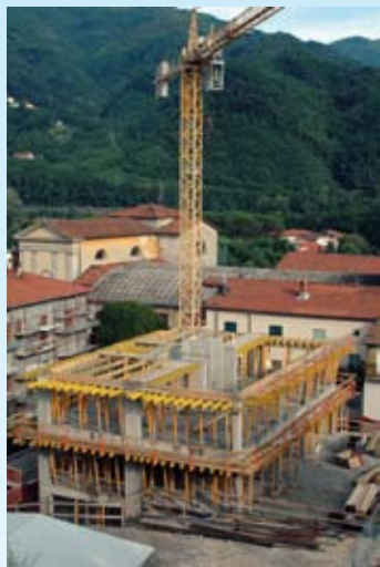
I lavori di costruzione della nuova sede
