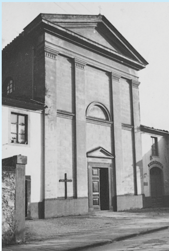
La sede storica della Misericordia in Via Roma, 25 (a destra della chiesa)
